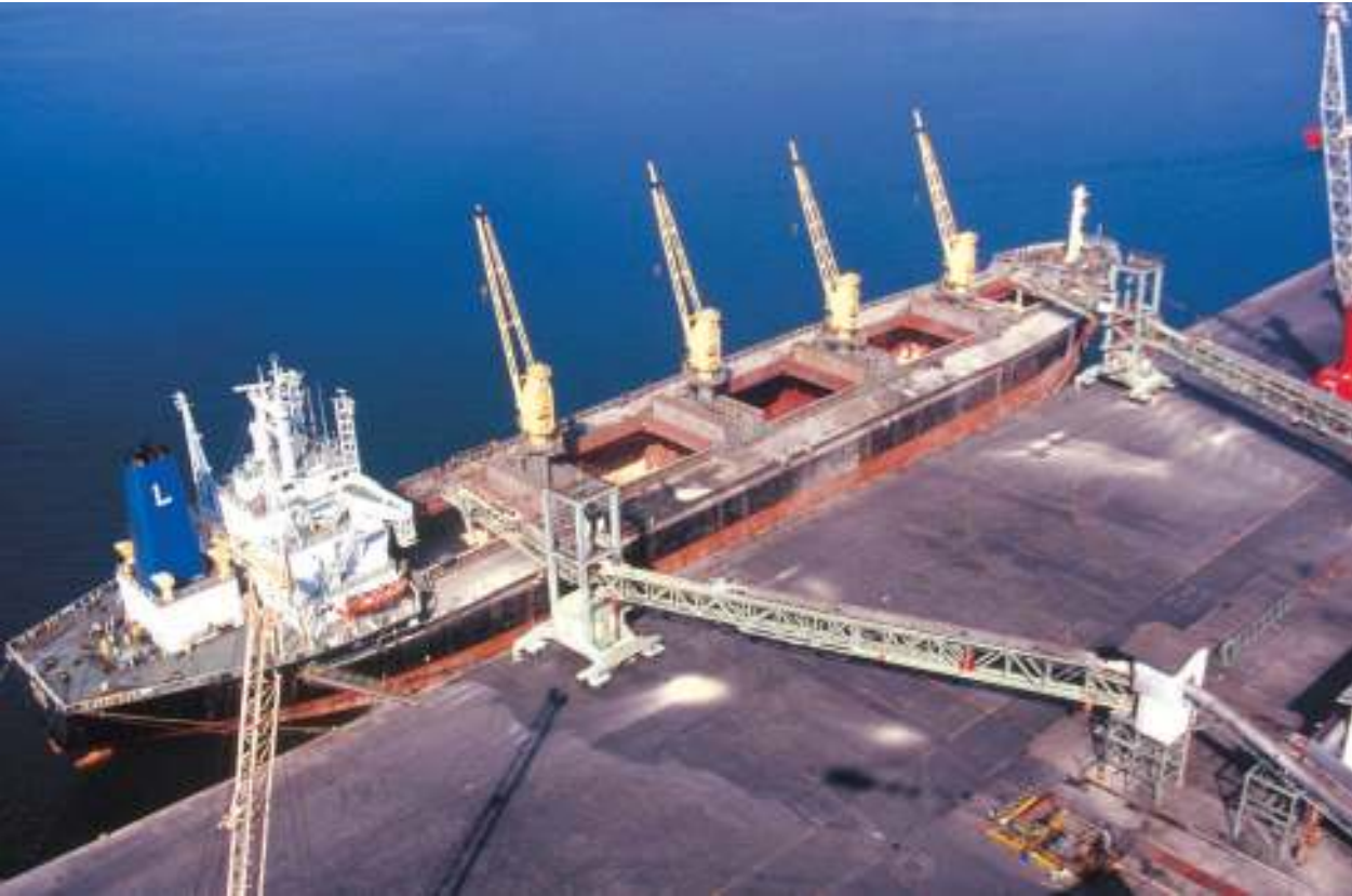
Puerto Quetzal. Carga de azúcar a granel, efectuada por la Exportadora de Granel, S.A., que presta servicios de exportación de azúcar a todos los ingenios guatemaltecos. Es una moderna terminal de carga. Puerto Quetzal inició operaciones en 1985, con la carga de azúcar transportada en bolsas de papel, que se rompían sobre la cubierta del barco para su descarga. Era un sistema lento y engorroso.
