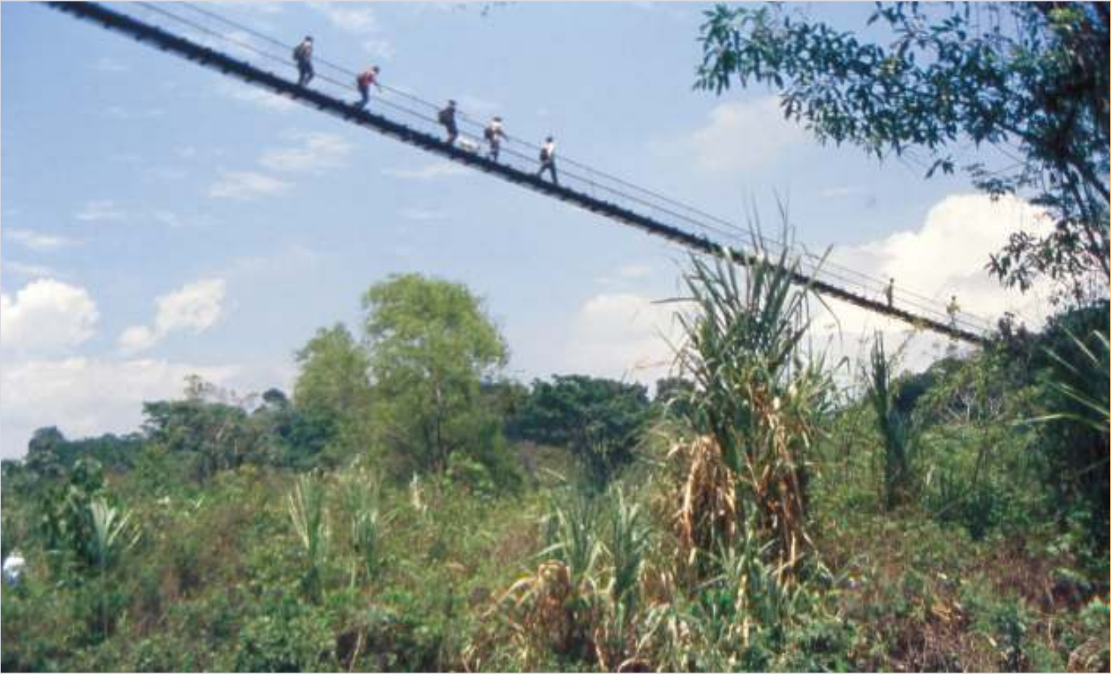
Puente colgante bien construido que comunica Los Tarros —al oriente— con las fincas Santa Sofía y Morelia. La estructura permite cruzar el río Gobernador, uno de los afluentes del río Pantaleón. Un día, cuando el puente era más sencillo en su construcción, un rayo mató a un transeúnte que atravesaba el río y a quien la tormenta no le permitió moverse con soltura. Este lamentable accidente motivó a los vecinos del lugar a gestionar ante las autoridades una instalación más adecuada.
