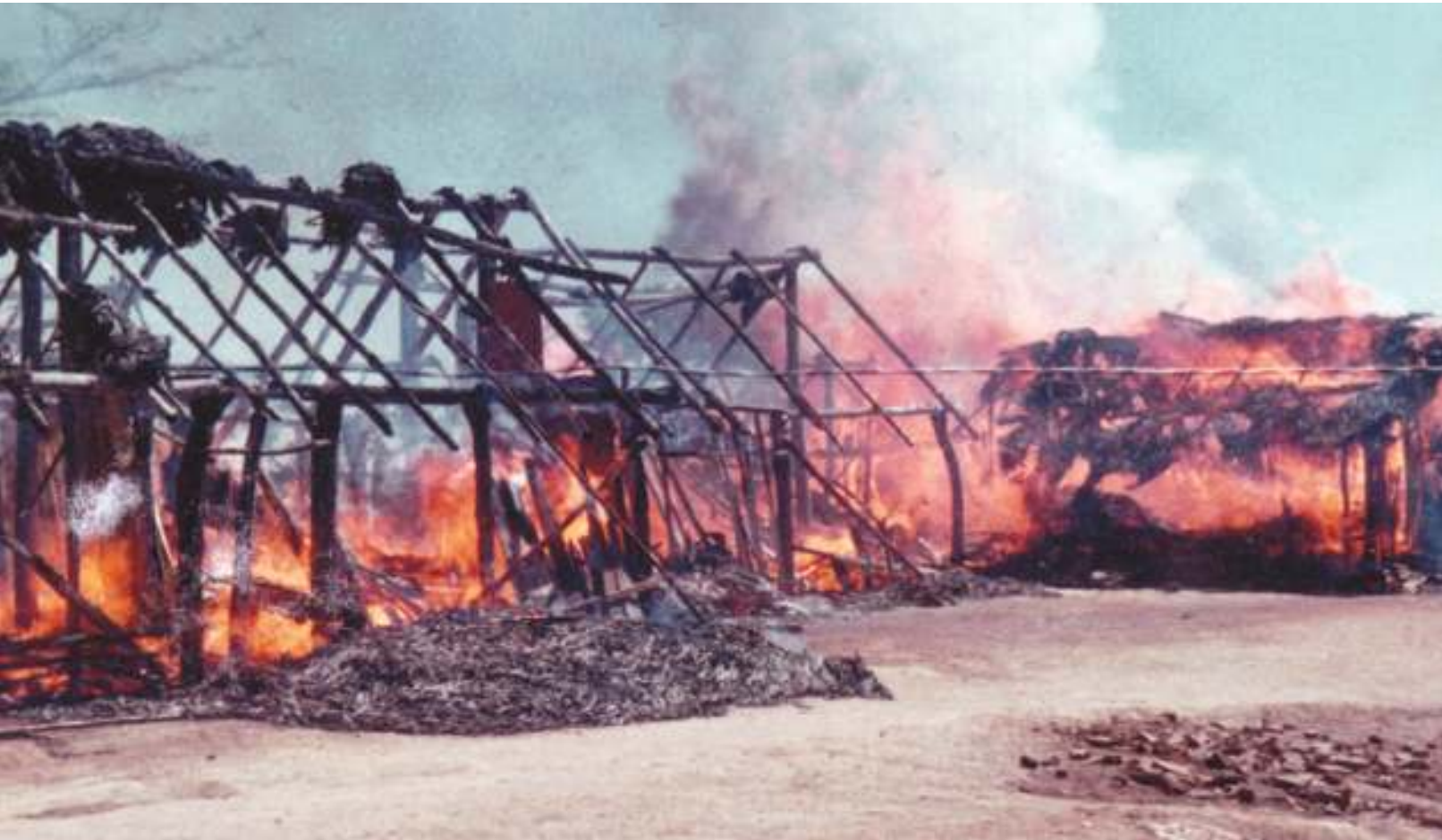
En 1969, un incendio consumió los ranchos situados en la ruta al área en que actualmente están instaladas las cocinas industriales.
