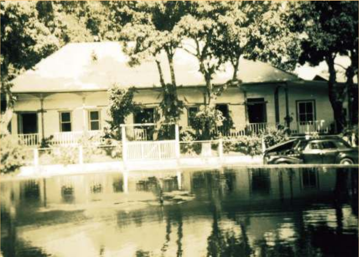
Casa-hacienda de la finca Los Tarros, construida a inicios del siglo XX. Ha permanecido durante cien años como vivienda, y actualmente es utilizada por el ingeniero Sergio Cabrera, Superintendente de Fábrica del Ingenio Los Tarros.
